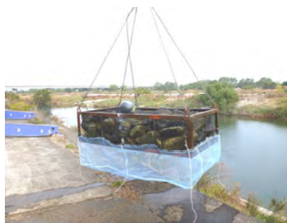
石倉の設置(揖保川)
