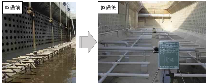
老朽化した散気装置を更新
