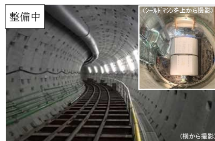
河川改修(地下貯留管)
