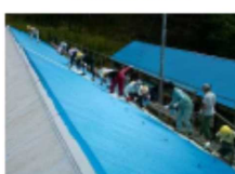
旧北屋長屋の修繕
