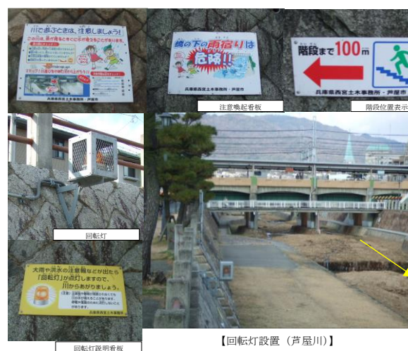
図 3-28 回転灯の設置
