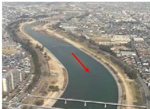
図 2-3 下流部築堤区間
