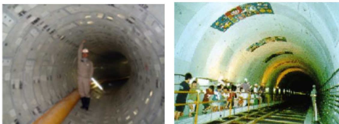
図 3-5 雨水貯留管（左：西宮市、右：伊丹市） （出典：西宮市下水道ビジョン、伊丹市ホームページ）
