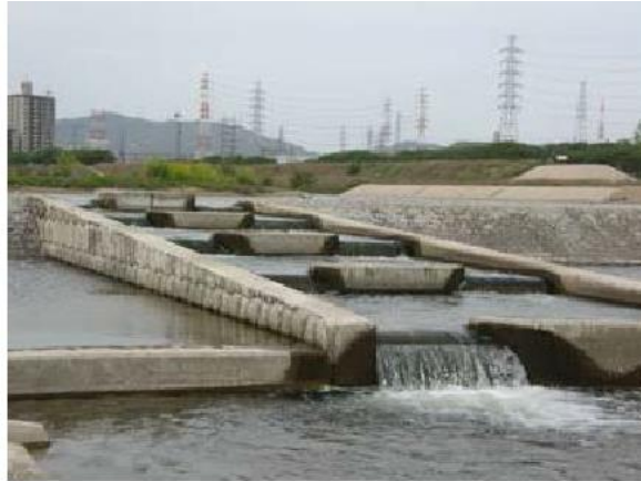
図 2-8 床止めに設置された魚道
