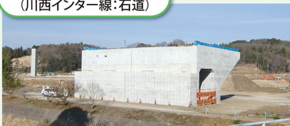
石道出合橋A2橋台 (川西インター線：石道)
