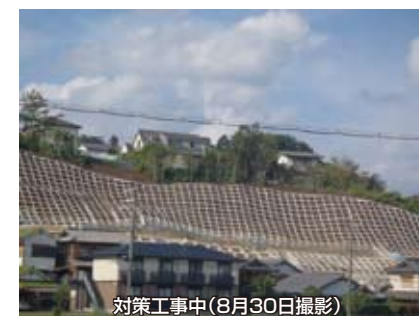
対策工事中(8月30日撮影)
