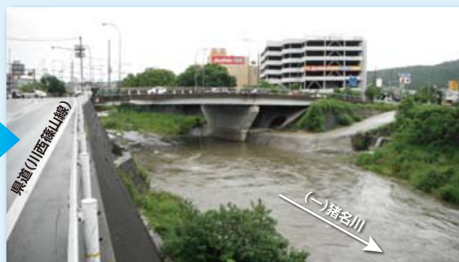
掘削後の状況(H24年6月)
