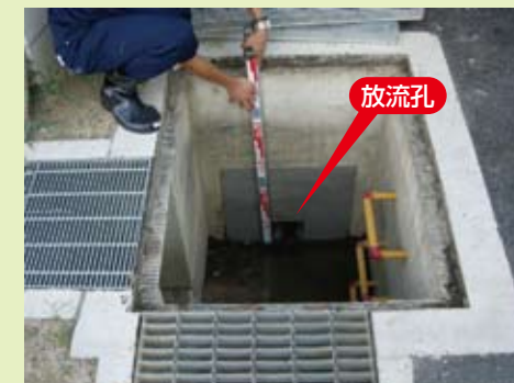
貯留した雨水は、放流孔(約10~20cmの小さな穴)から少しずつ校外へ流します
