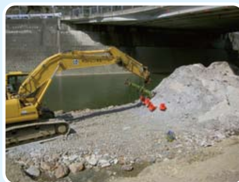
掘削工事の状況(H24年4月)
