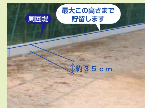
校庭を「周囲堤」で囲み、雨水を貯留します
