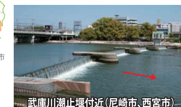
改善指標②海と川の連続性を確保すべき場所
