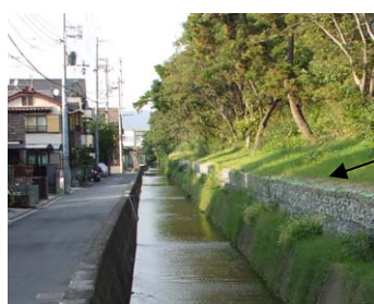
写真 4.1.1 ドレーン工法※の施工例
